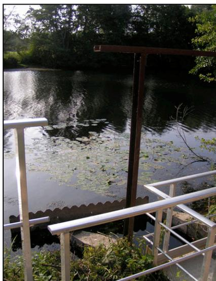
**FIGURE 19** : *Dégrilleur servant à éliminer les principaux résidus de l'eau de l'Orne, prélevée pour l'usine d'AEP de Louvigny.*
