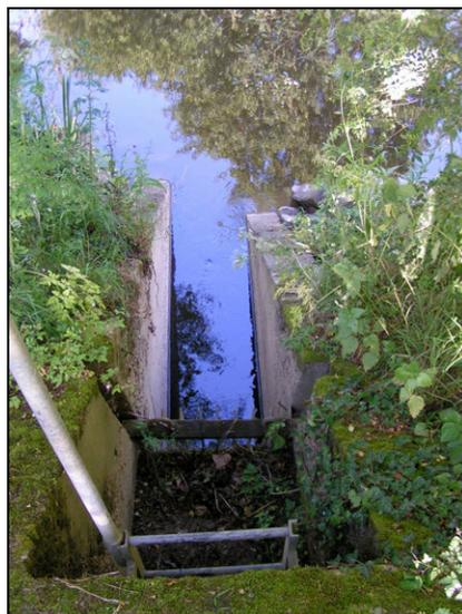
**FIGURE 23** : Dégrilleur servant à éliminer les principaux résidus de l'eau de la Vire, prélevée pour l'usine d'AEP de Saint-Lô.
