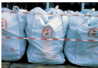
© INRS Déchets amiantés
