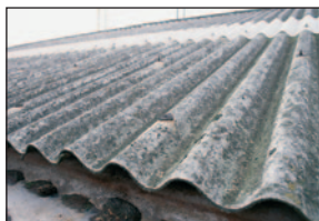
© INRS Toiture en amiante ciment
