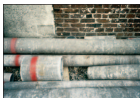
© INRS Canalisation en amiante ciment
