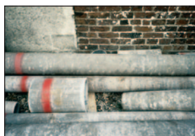
Crédits : INRS Canalisation en amiante ciment
