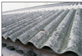
© INRS Toiture en amiante ciment
