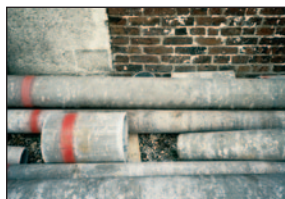
© INRS Canalisation en amiante
