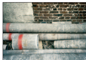
© INRS Canalisation en amiante ciment
