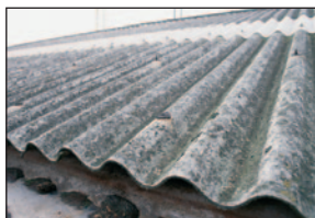
© INRS Toiture en amiante ciment
