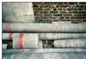
© INRS Canalisation en amiante
